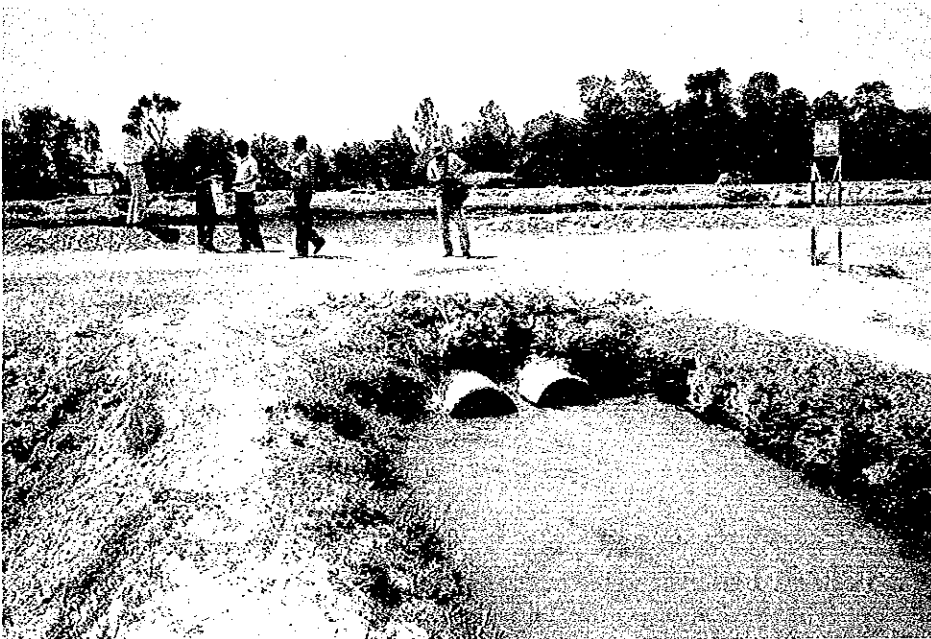
⑤ ハルドイ支線から 三次水路への取水口
