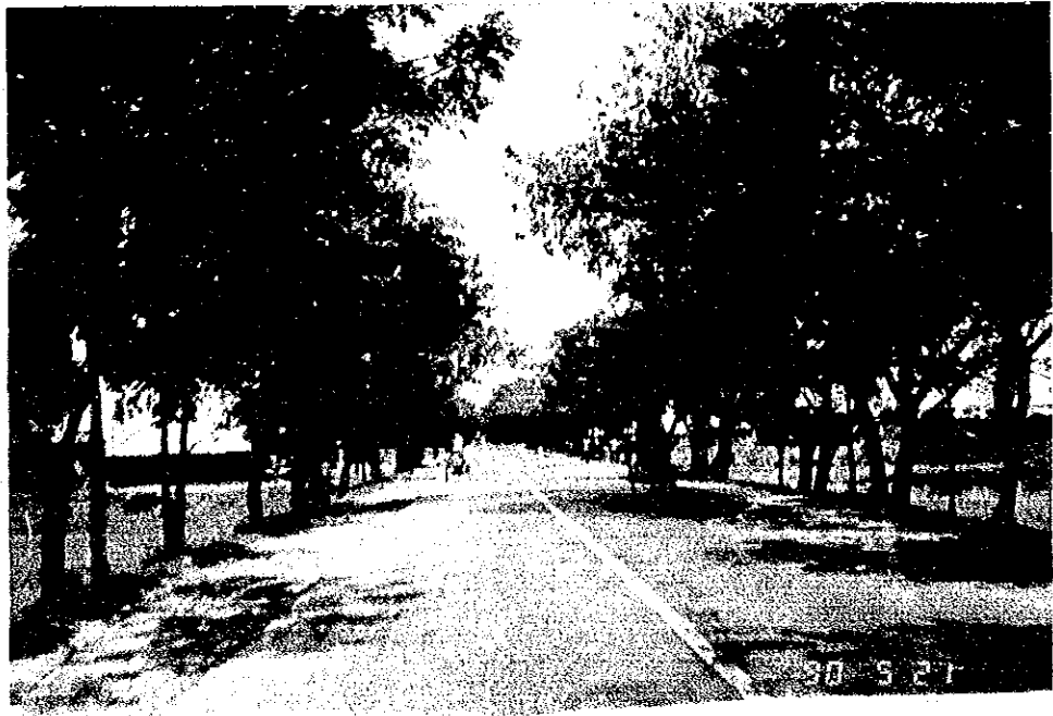
ダッカ～チッタゴン国道の現況 (シタラキヤ橋を過ぎると道路幅は急に狭くなる)
