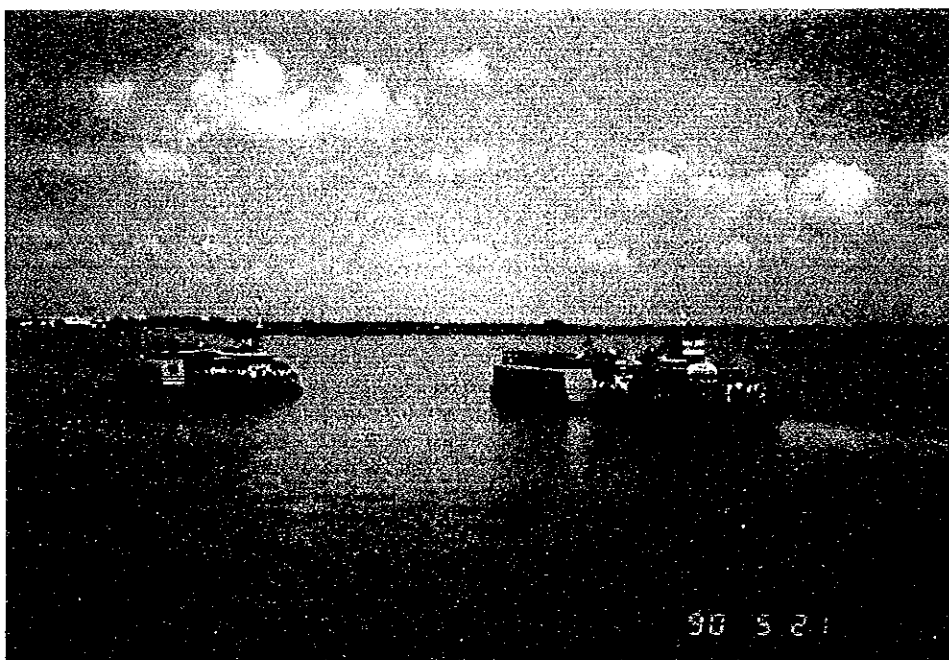
本計画架橋地点付近の状況 (架橋中心線は中洲付近で現フェリー 航路の約 150m 上流側)
