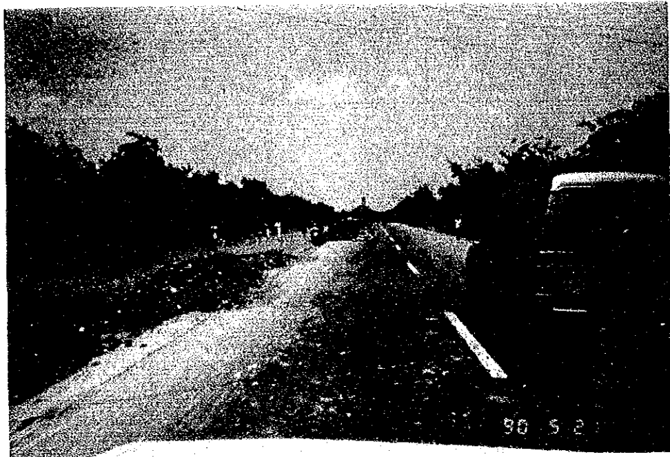
ダッカ～チッタゴン国道の現況 (ダッカ～シタラキヤ間の拡幅工事)
