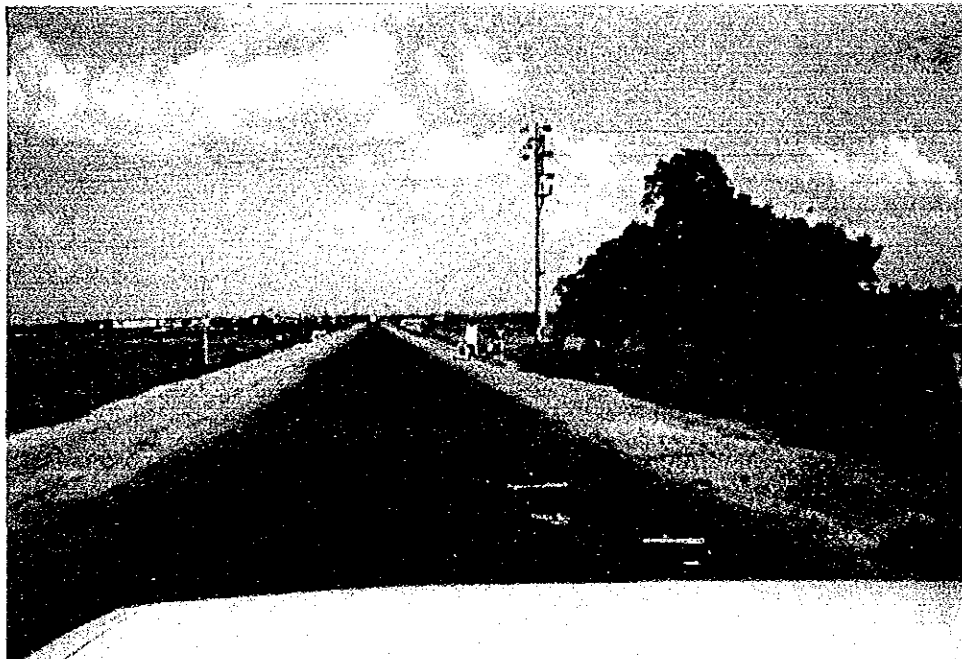
ダッカ～チッタゴン国道の現況 (写真は本計画コミラ側取付道路終点付近、 1991年6月までに写真上のごとく工事完了予定)
