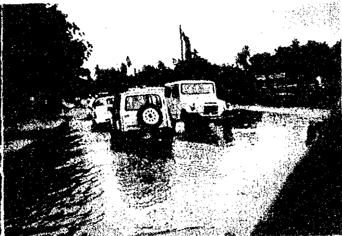
路面排水の不備
