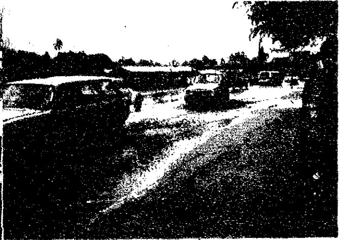
幹線道路での排水不良
