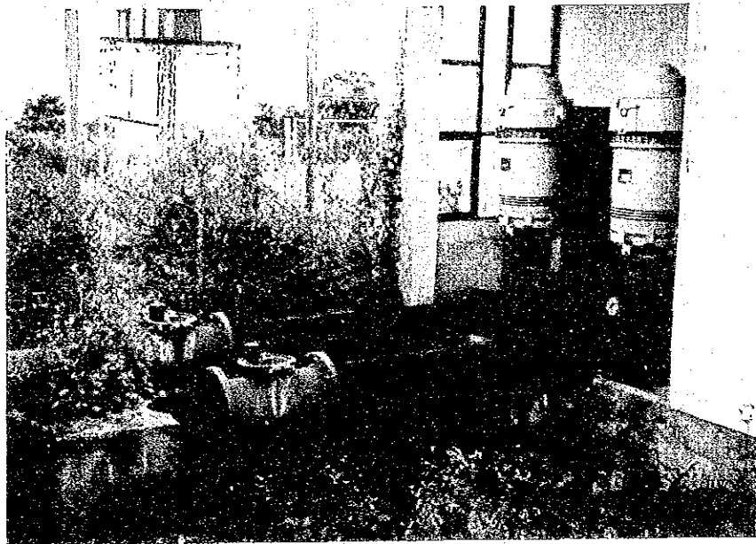
カラカラ加圧基地内 取り替え予定の パーチカルタービンポンプ
