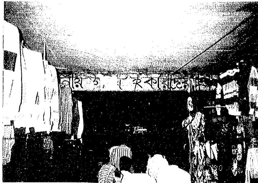
D 3 3 陸橋の下はこの通り。 不法占用のマーケットと化している。
