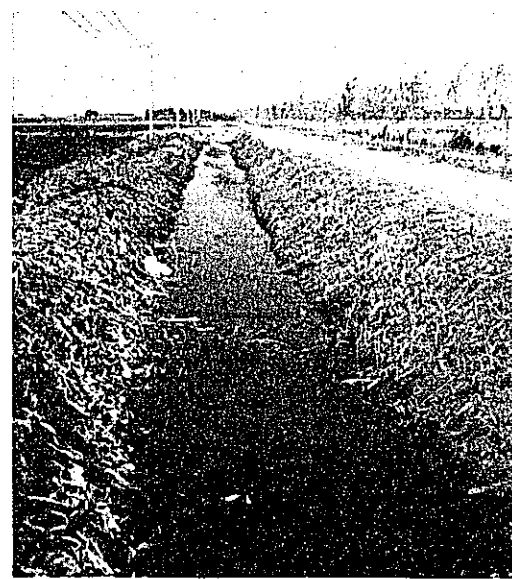
▲②展示圃場内の排水渠道 (圃場内排水路)
