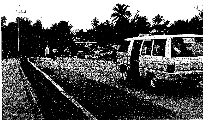
ジャンビ市新市街 (排水溝が整備 されている)
