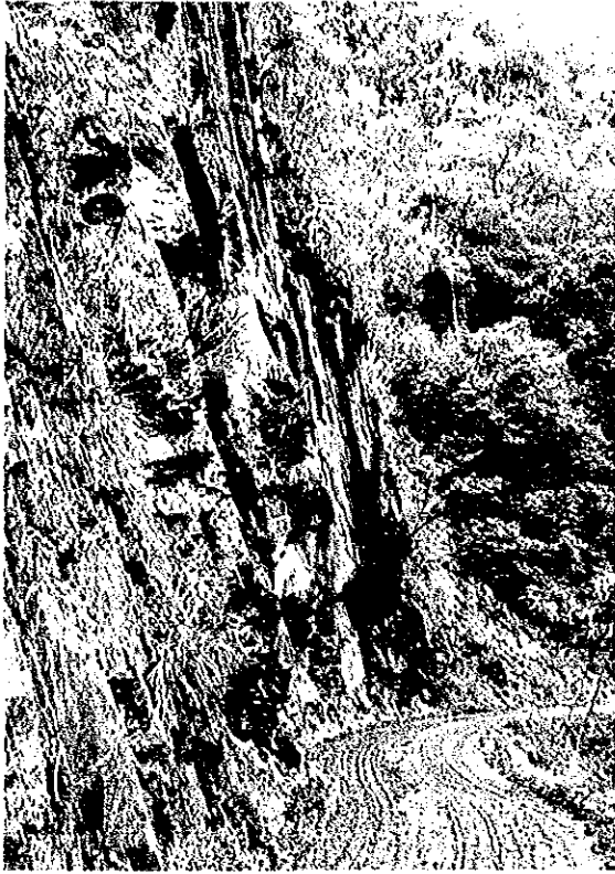
写真4 起点から14km付近における現道は幅員が狭く、排水施設も不十分である。
