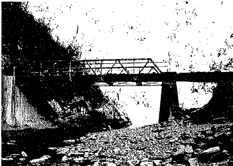
写真6 プエルト・レオン付近のトラス橋。この橋は古く、部分的にいたんでおり、木製の床板が応急的に使用されている。
