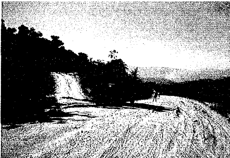
写真12 終点のベジャピスタにおける道路状況。本地点か ら先はSNCにより既に改良済みである。
