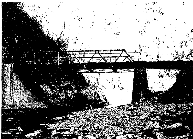
写真6 プエルト・レオン付近のトラス橋。この橋は古く、部分的にいたんでおり、木製の床板が応急的に使用されている。
