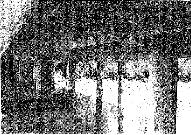
(16-a) Pile bent pier
