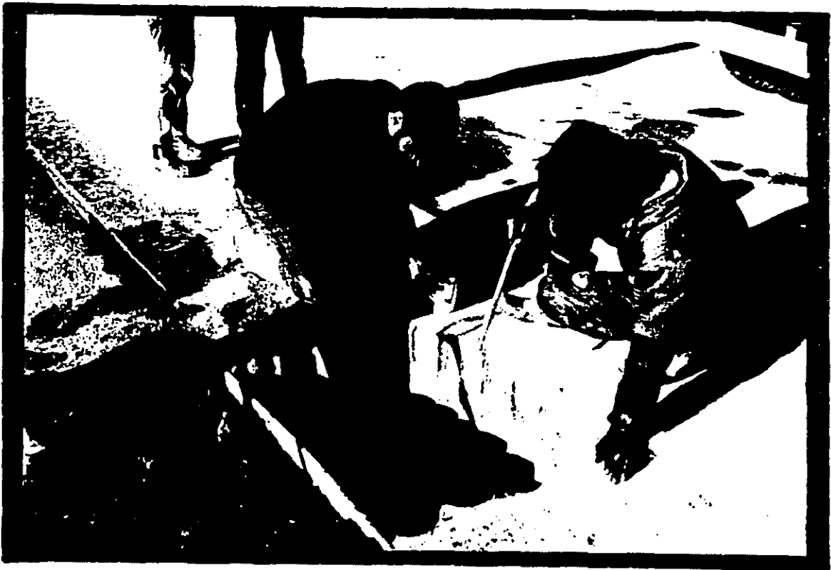
Preparación de superficies de hormigón para recibir el hormigón de reposición; se coloca puente de adherencia Sikadur 32 en una altura de 15cm aproximadamente
