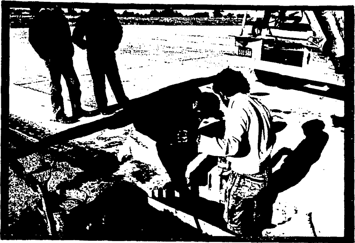
Preparación de superficies de hormigón para recibir el hormigón de reposición; se coloca puente de adherencia Sikadur 32 en una altura de 15cm aproximadamente
