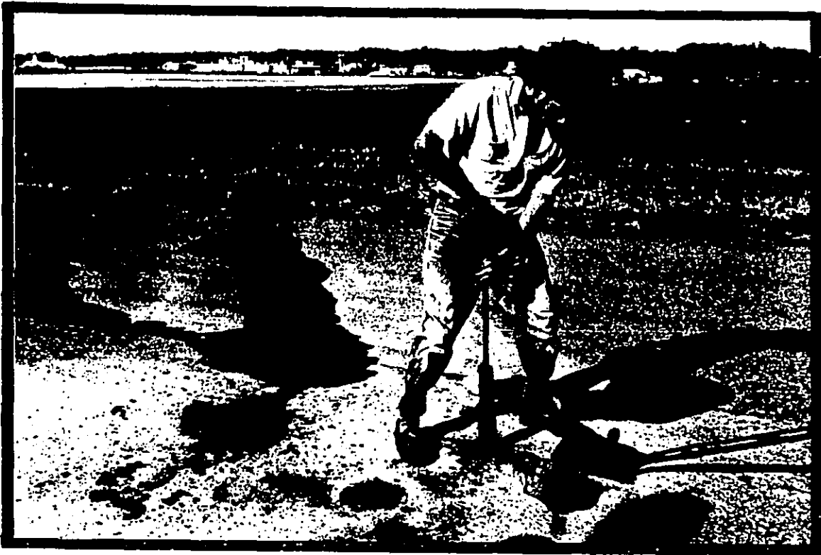
Operación de reposición del pavimento en el punto 14
