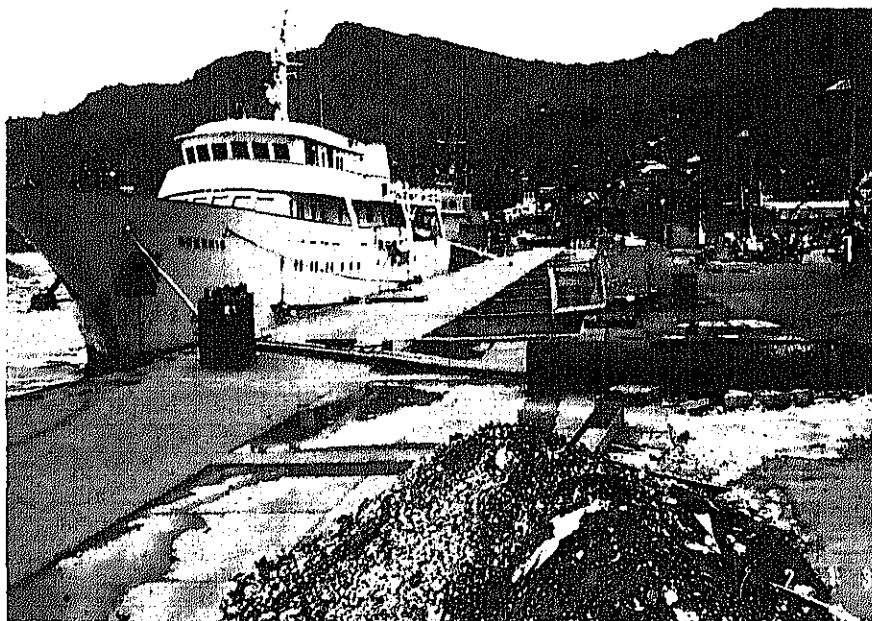
旧マグロ岸壁の破損状況
