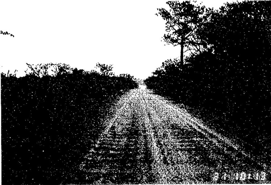
写真 3. 計画道路 路面波状凹凸状況
