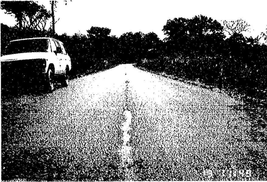
写真 5. 既設舗装磨耗状況
