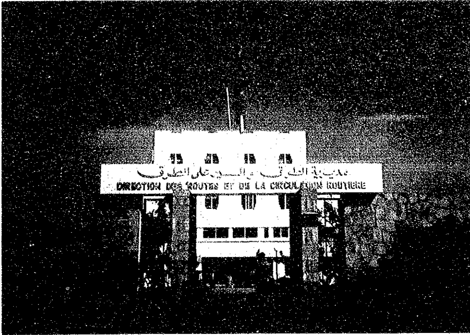
モロッコ国道路・道路計画局（DRCR）本局舎（ラバト市）
