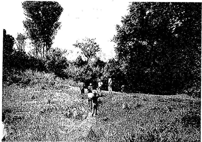
⑤ サメンデニダム予定地点 手前の穴はダム軸ボーリングの跡。 堤高17.5 m、堤長1,850 m、貯水容量5億5千万 m^3 を予定している。
