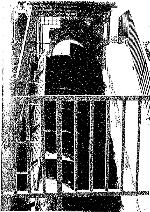
① ② テベ地区揚水ポンプ場 H = 7\text{ m} , 50\text{ rpm} , Q = 1,200\text{ l/s} アルキメデススクリュウ型ポンプ
