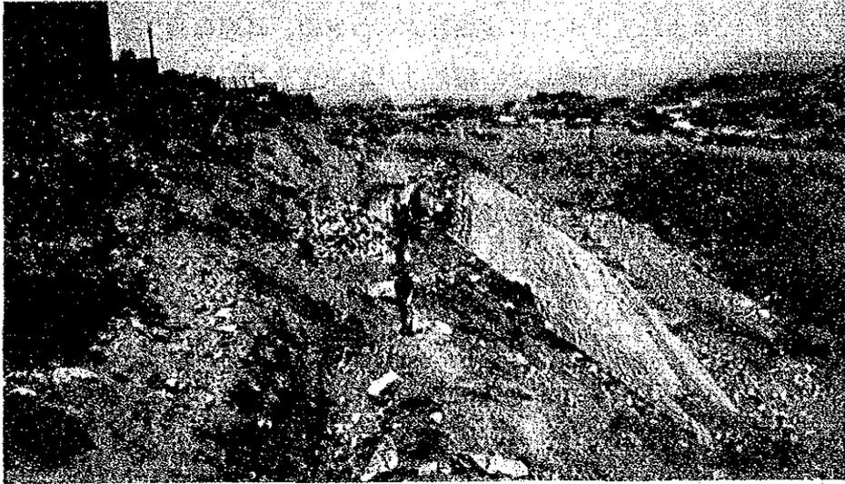
このように被害が拡大した直接的な原因は、切土掘削工事後に斜面保護工事を予算不足のため中断され、切土部分そのまま放置されていたことにある。一般的に切土部分の放置は乾期には斜面の構造上大きな影響を受けないが、雨期の降雨に対しては非常に大きな被害が出るものであり、従って、この放置期間に年2回ある雨期の前期（3月～4月）の雨水の浸食は当斜面に大きな影響を与えたと言える。さらにサブセンターの建物の構造が一体化されたRC造であるため、建物北東部の沈下に対して建物構造全体が持ちこたえさせたことも結果的には被害の早期発見を遅らせることになった。
