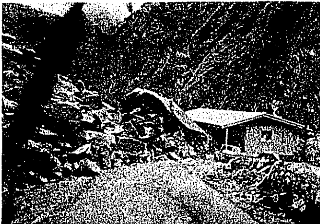
写真-7.3.59 Baguio 側の Kennon 道路の崩落岩塊
