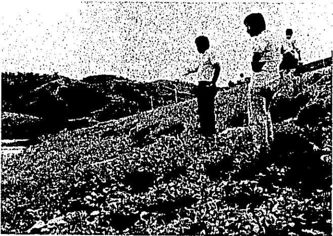
写真 7.5.44 マツウタム上流法面のすべり
