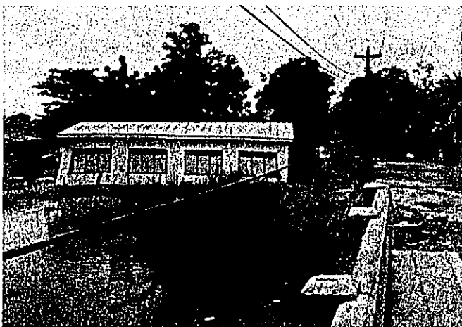
写真-7.3.35 バランガイ Pugo 内の道路 (地盤沈下により川の水より低くなっている)
