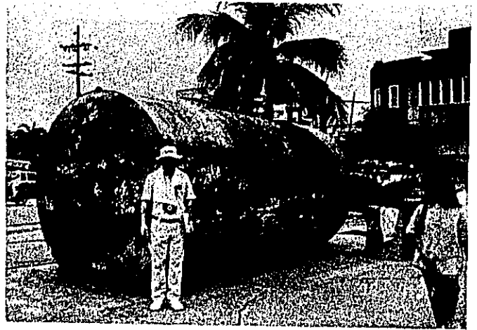
写真-7.3.26 掘り出された地中タンク
