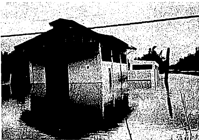
(21-c) 近くの建物が沈下
