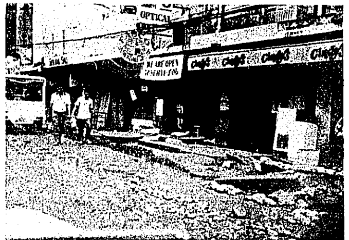
写真-7.3.28 Dagupan 市内 (路面の玉石は応急嵩上げ資材)
