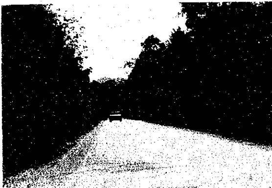
国道3号から内陸に入る規格の低い国道区間
