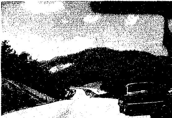
将来の6車線化を見込んだ道路用地幅
