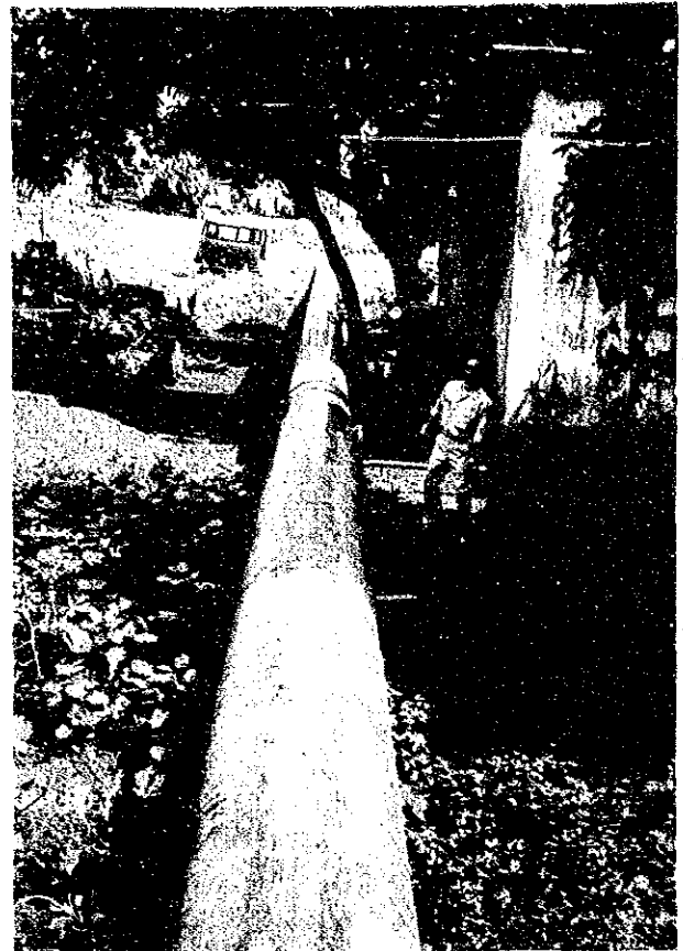
既設φ700、 地上配管である (距離 12.2 km 附近)
