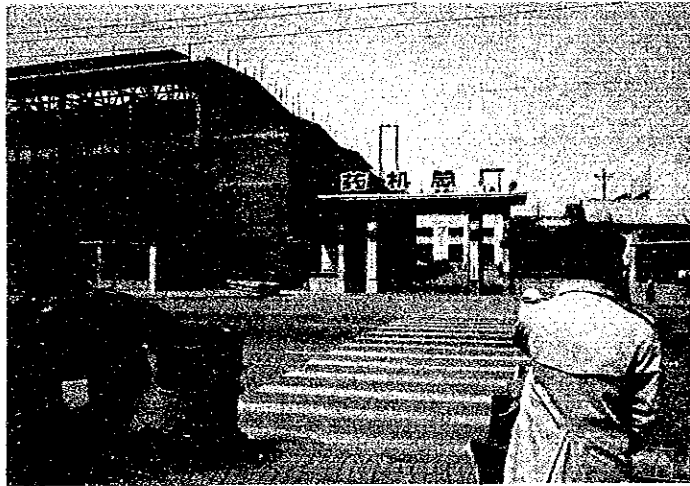
工場正門 (ガラスライニング工場建屋新築中)
