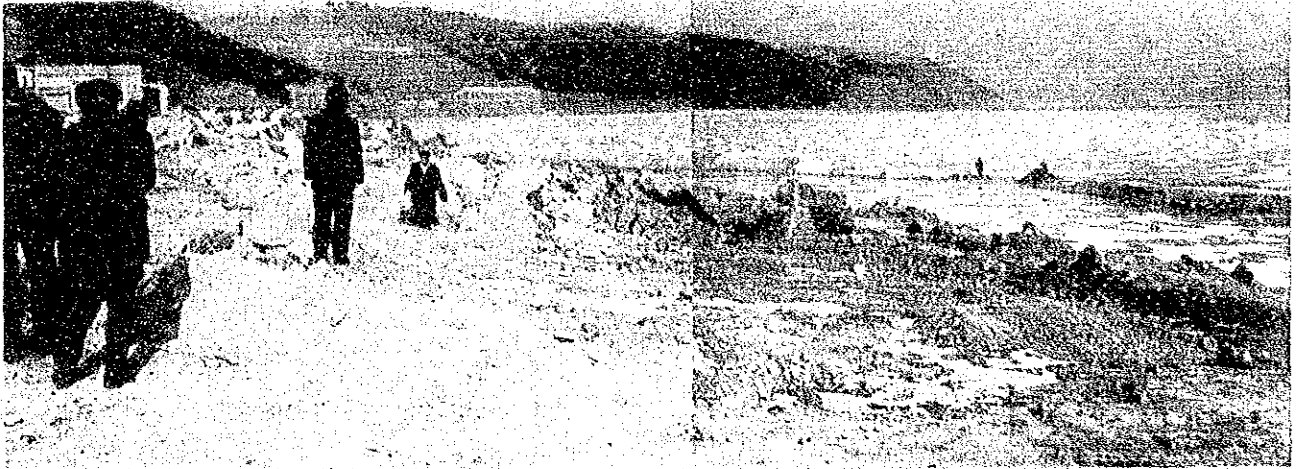
取水ポンプ場建設予定地（左端は既設の取水場）
