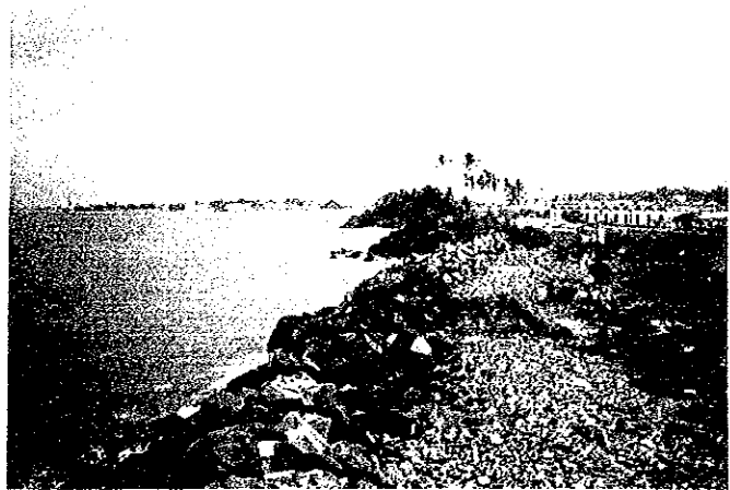
毎年南西モンスーン期に被災する 石積防波堤～護岸
