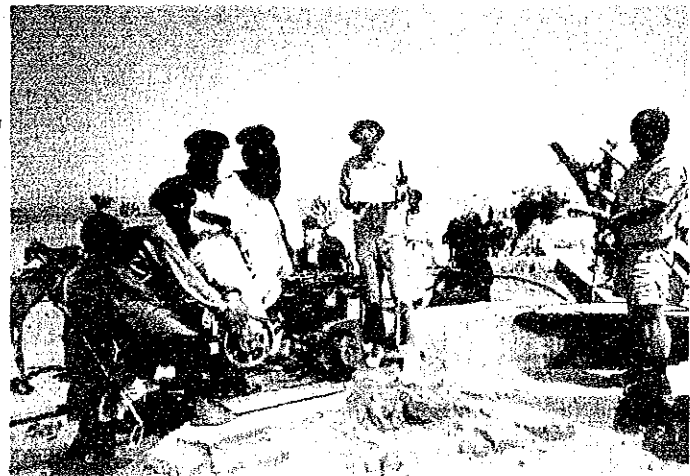
Puisage à la pompe "Mono-lift"
