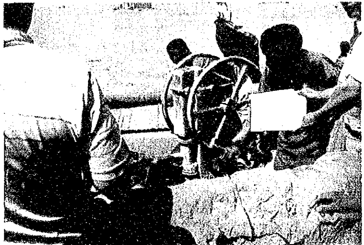
デューバポンプによる 人力揚水状況 ハンドルが重く揚水量も小さい
