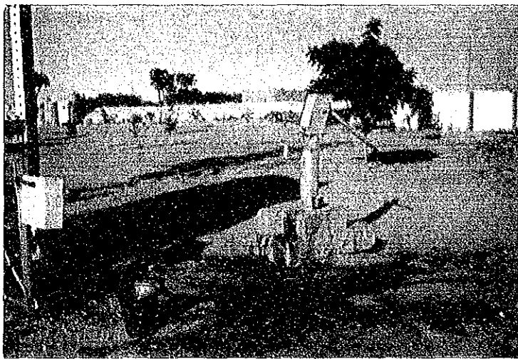
インディアンポンプ付き 管井
