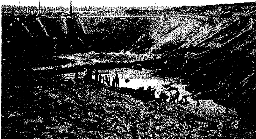
一級揚水機場予定地
