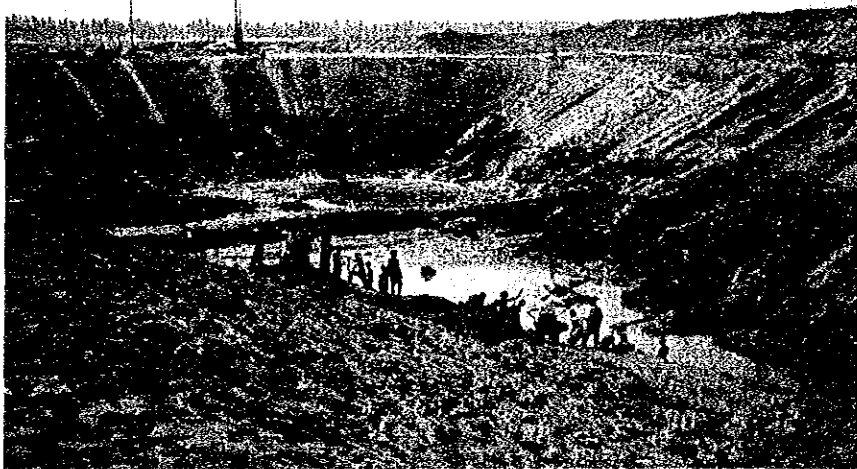
一級揚水機場予定地
