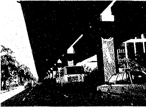
▲アヤラジャ高速道路 (Ayer Rajar Expressway : AYE) の高架橋区間 (周辺土地利用との調和、圧迫感等により、 政府内部では評価が高くない)
