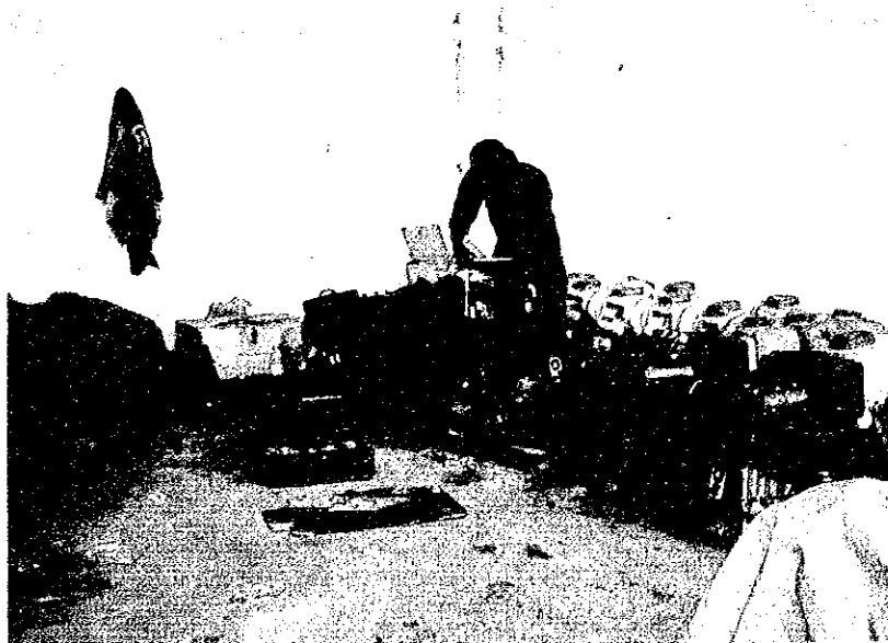
散布機の補修
