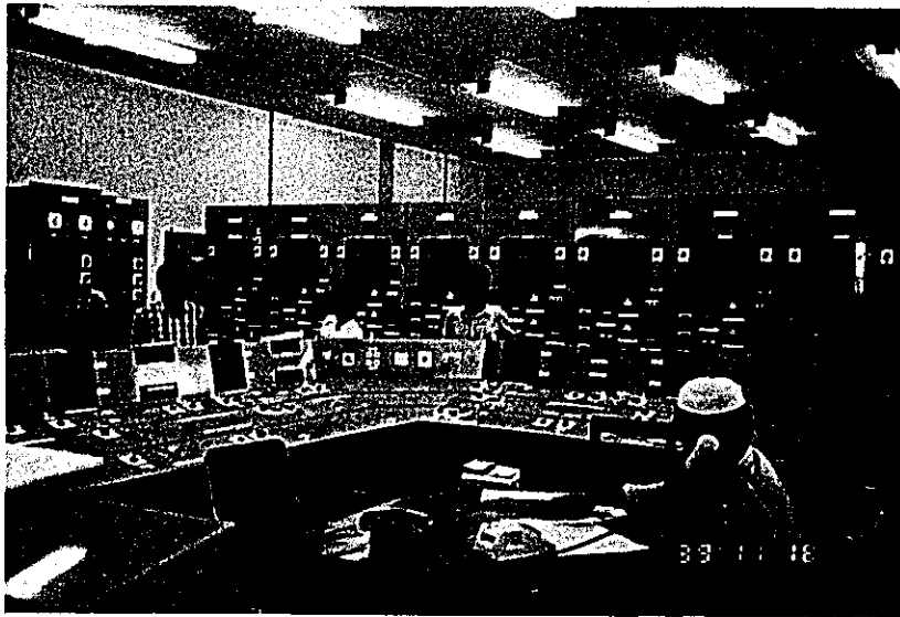
Siddhirganj 変電所制御室
