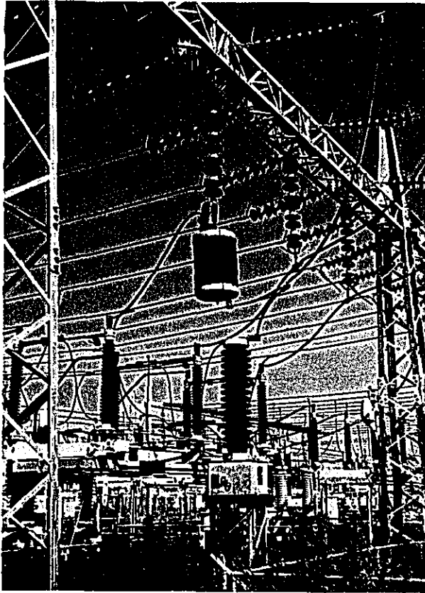
PLC用ブロッキング・コイル 及びカップリング・コンデンサー (Ashuganj発電所)
