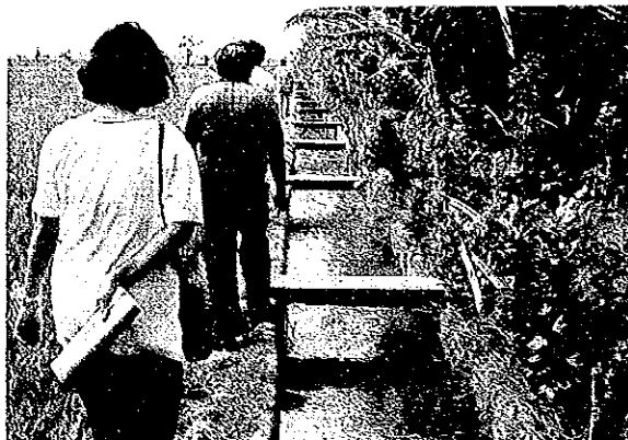
San Benito地区C I S (Laguna州) (最近の改修工事によりライニングされた水路)
