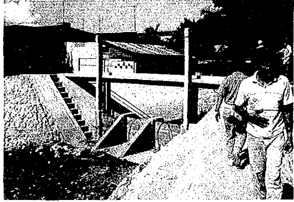
San Antonio地区C I P (Pampanga州) (新規事業として新たに頭首工を建設中)
