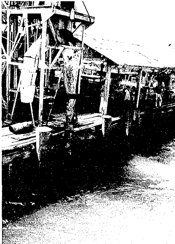
SANDAKANの民間企業の水揚げ基地 けい留施設が不足している場合は軽易な木製 の浮棧橋を設置してしのいでいる。
