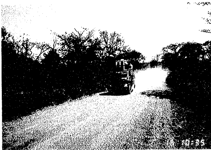
Photo 2 Etat actuel de la route du projet
