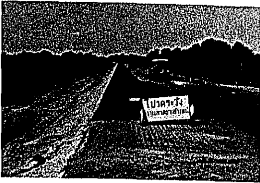
〔路肩の舗装改良工事〕
