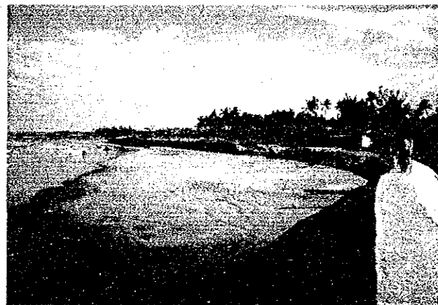
▲高波による堤防の被害
