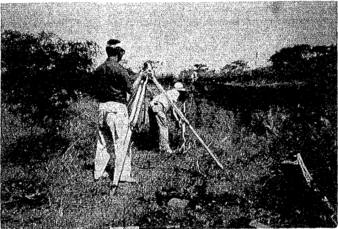
堤体及び洪水吐工 決壊状況調査（決壊箇所右岸側）
