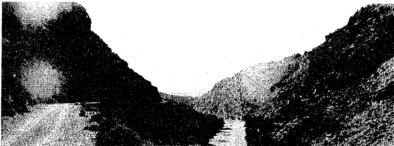
Site de barrages de Timkit(n° 16)
