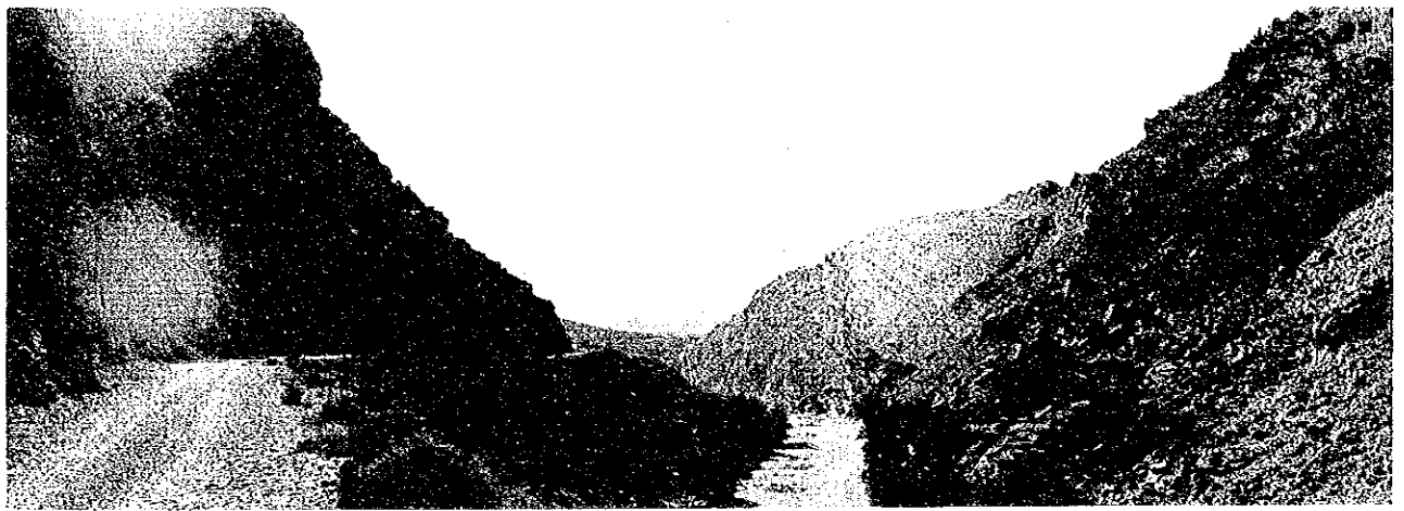
上流側より見た Timkit (No. 16) ダムサイト
