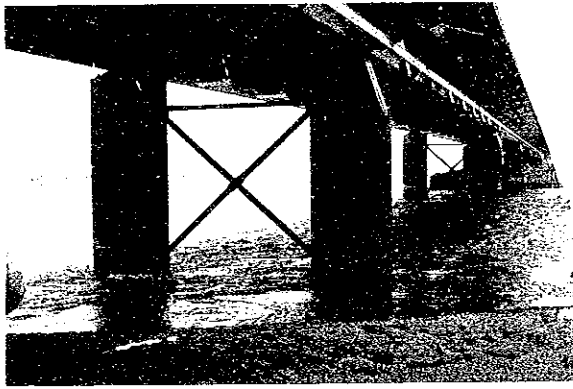
鋼トラスを支えるパイル・ベント橋脚 (橋脚の腐食がひどいと報告されている。)
