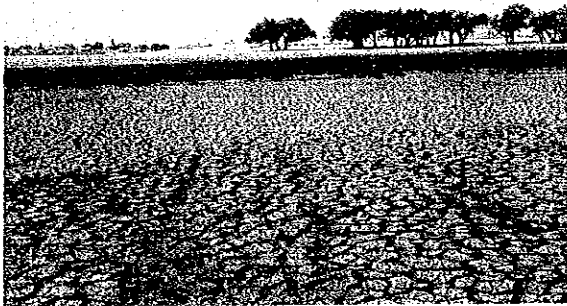
オムドルマン側の取付道路付近の川岸 (ここは洪水期には氾濫する。洪水が引いた 後には無数の地割れが発生する。)
