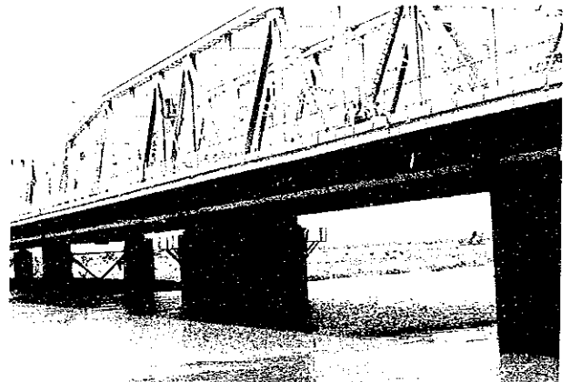
旋回桁を支える大型橋脚 (旋回桁のウェッジがさびついて動かなくなり、今ではもはや上部工を十分支持出来なくなっている。)
