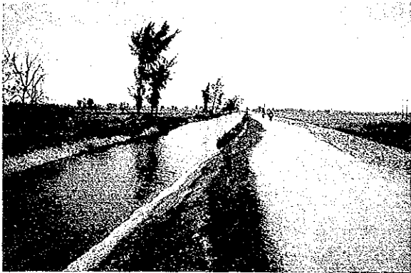
百曲園分水工西用水上流から 道路拡巾中
