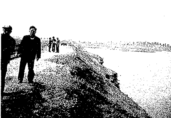
16.4 大田園盛土法面状況
