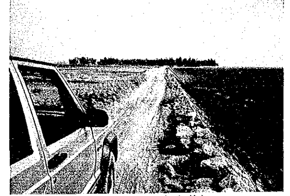
16.2' 改修堤防石積・盛土状況
