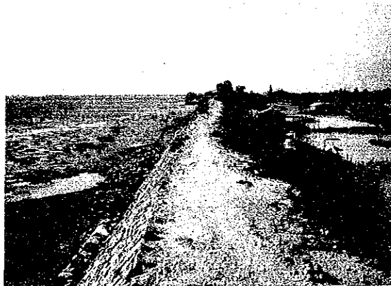
117 百曲圍改修前堤防
