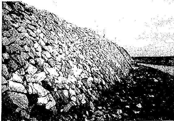
116 百曲圍改修前堤防石積状況
