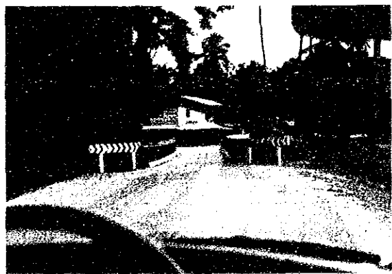
10号線（タゴン～ダム）橋は未改良
