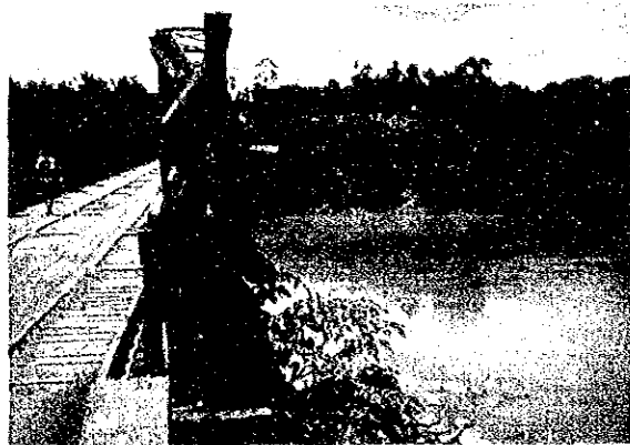
ナムグム川支流 (破損状況)
