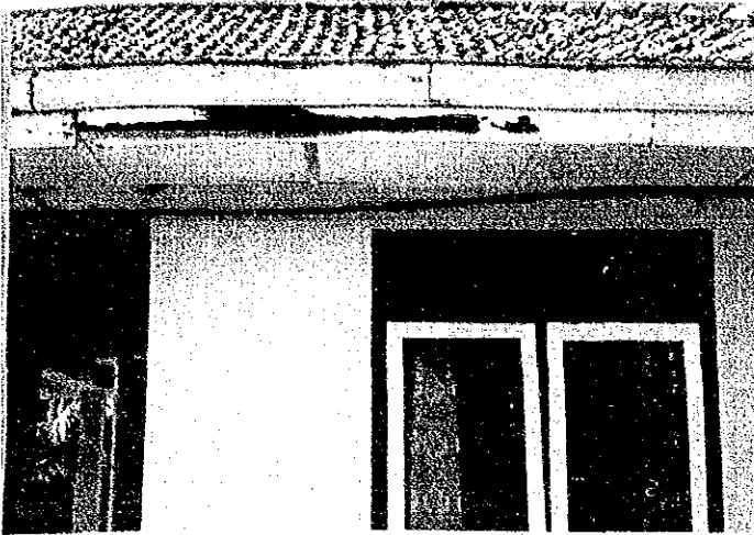
庁舎屋根(腐蝕により剥離)
