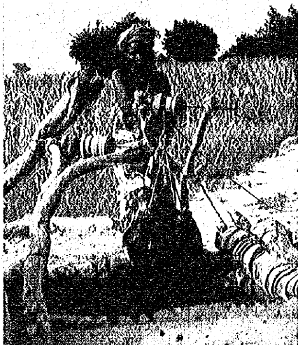
P-8 伝統型井戸における水汲み (木製滑車を使った珍しい例)
