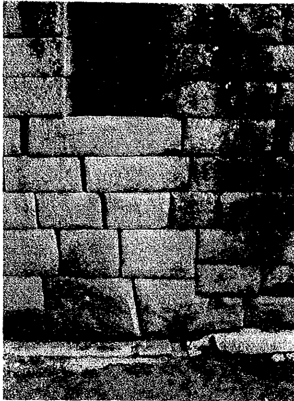
太陽の神殿地上階内側壁面状況
