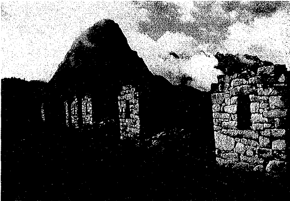
壁長の小さい壁の崩壊
