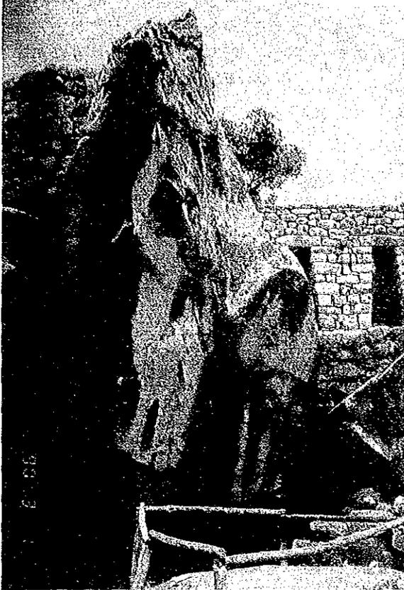
1) 図4-⑨地点。「コンドルの神殿」南側の自然石。基底部の節理がゆるみ不安定
