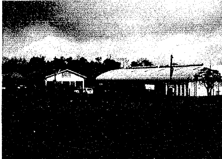
ベラビスタ営業所 事務所と倉庫
