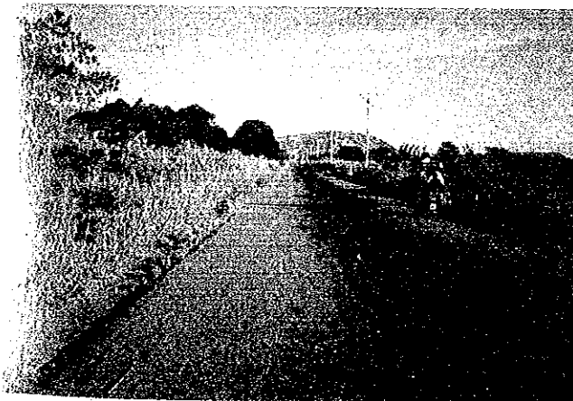
簡易舗装の道路 (ベゴナ村付近)
