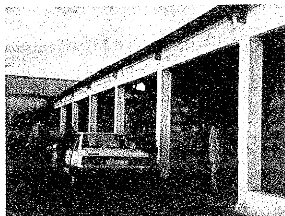
戸がない平倉庫
