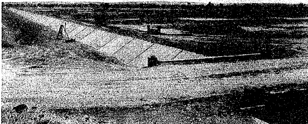
Canaux bétonnés d'irrigation
